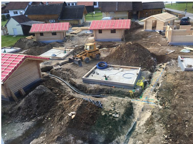
Bau eines Nahwärmenetzes für ein Hüttendorf mit 11 Häusern
