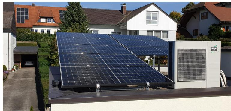
Mehrere Unterkonstruktionen mit Trapezblech in Form eines Pultdaches mit Einhaltung der Bauverordnung für genehmigungsfreies Errichten. Die Anlage gilt als Dachanlage - die erste in Bayern - auf einer Freifläche.
